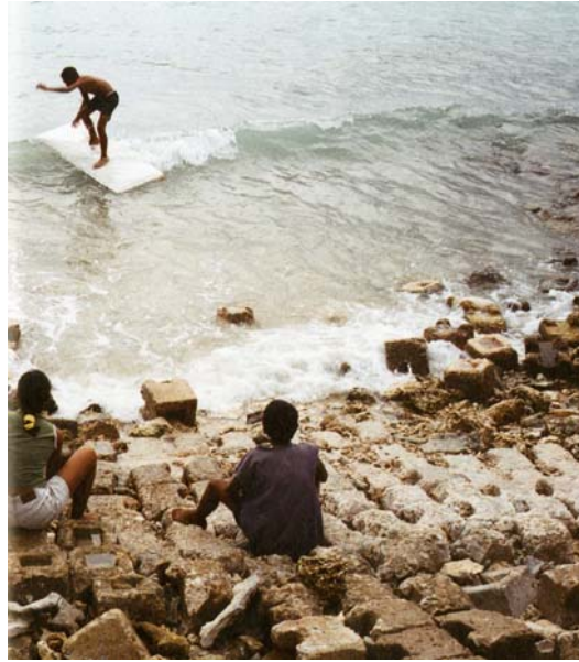
Figure 28: destruction des édifices de consolidation des littoraux (Reeves H, 2007)
