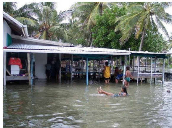
Figure 39: inondation des habitations de l'archipel (Reeves H, 2007)
